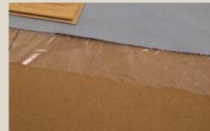
這一款地墊主要用于消除地面較大的不平整。可以和Quick Step快步的防潮地膜結合起來使用。不能用于地熱。
